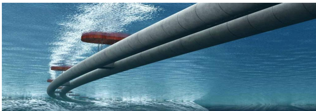
Рис. 1. Подводный мост на понтонах [3]
