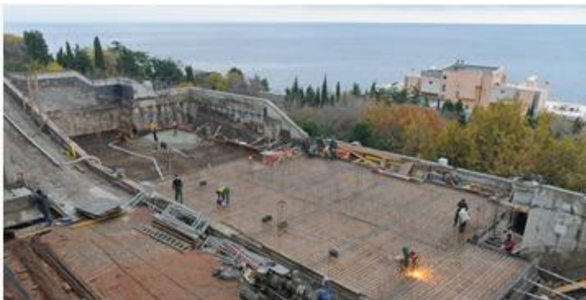
Рис. 1 – Организация строительной площадки в стеснённых условиях
