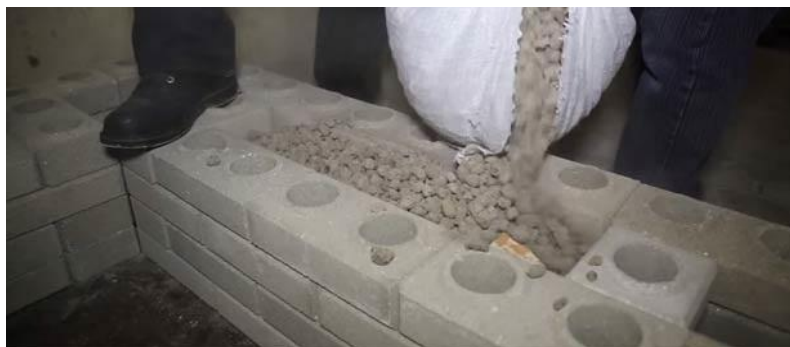
Рис. 3. Утепление ограждающей конструкции керамзитом [1]
