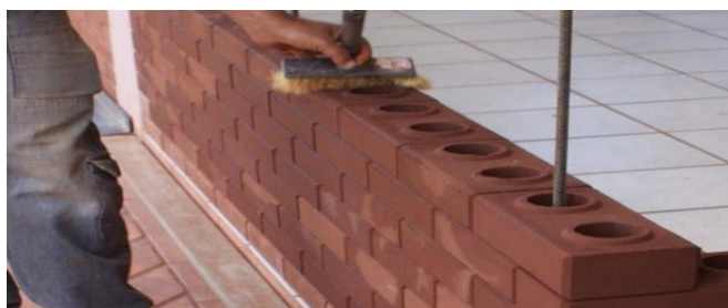
Рис. 2. Укладка кирпича «лего» с армированием пазов [1]
